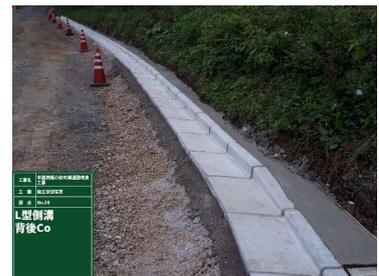
L型側溝背後Co打設
